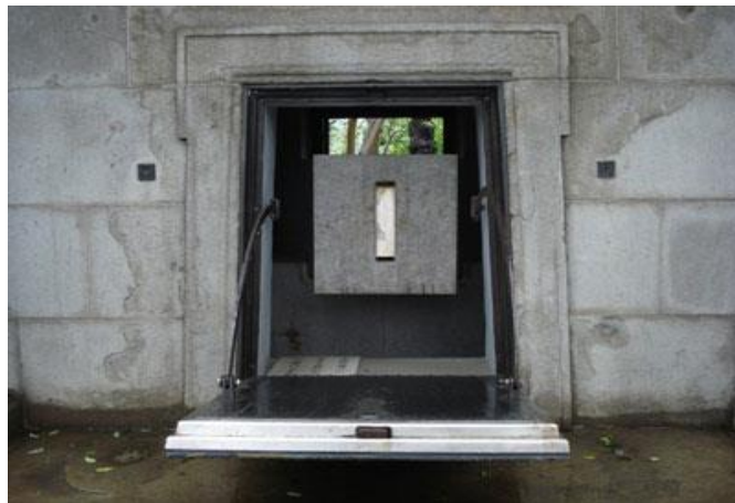
水準原点基礎図の「舟形台石」 ※長方形の白い石が水準原点
